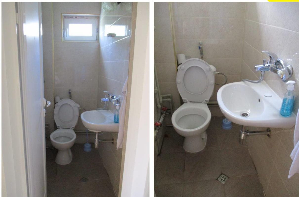
Тоалетна с мивка на първия етаж – след ремонта
